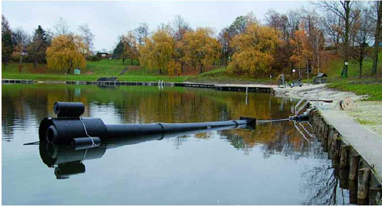
Bilder vom Einbau der Tiefenwasserbelüftungsanlage zwischen 04. und 15. November 2010. Dadurch ist die gute Wasserqualität des
