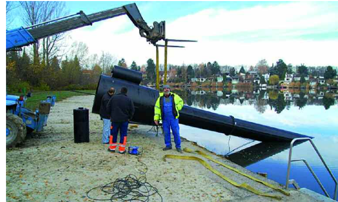
Bilder vom Einbau der Tiefenwasserbelüftungsanlage zwischen 04. und 15. November 2010. Dadurch ist die gute Wasserqualität des
